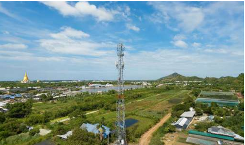
โครงการรวมโครงสร้างเสาสัญญาณระบบโครงข่ายเดี่ยว (Single Grid) คาดว่าจะแล้วเสร็จภายในปี 2568
